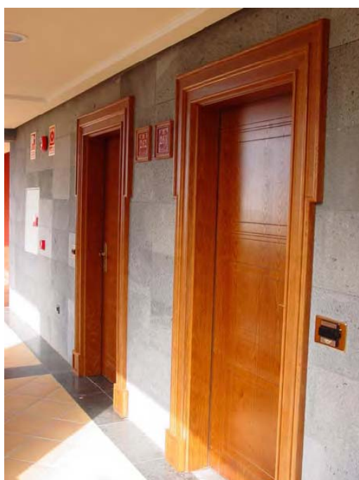
Control de Accesos
