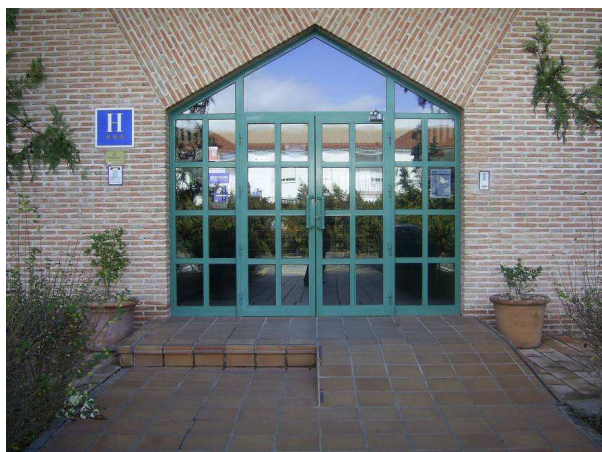
Exemplo de chanzo de acceso a Hotel salvado mediante rampla. Sería conveniente instalar na rampla un dobre pasamáns a ambos lados.
