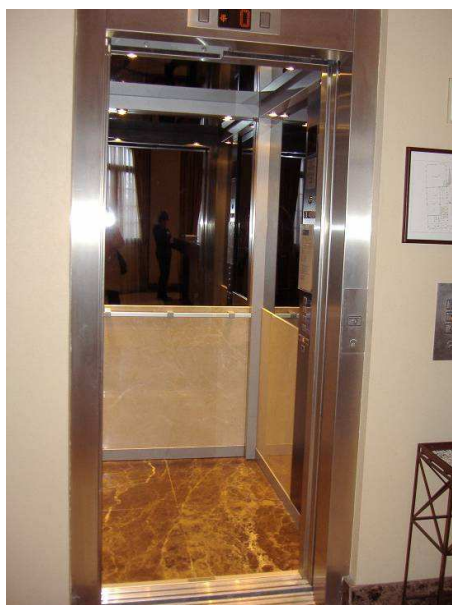
Cabina de ascensor accesible para unha persoa en cadeira de rodas.
