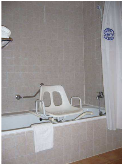
Bañeira con asento xiratorio e respaldo e bañeira con asento tipo táboa. Ambos asentos son de quitar e poñer.
