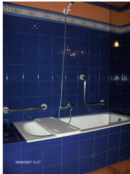
Bañeira con asento xiratorio e respaldo e bañeira con asento tipo táboa. Ambos asentos son de quitar e poñer.
