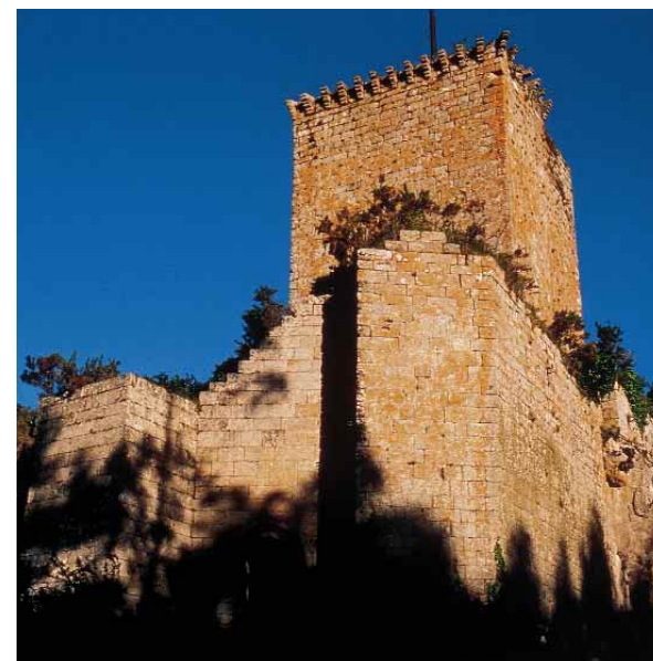
Castelo dos Andrade, Pontedeume (A Coruña)
