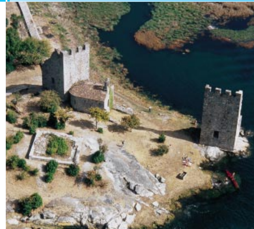
Torres de Oeste, Catoira (Pontevedra)
