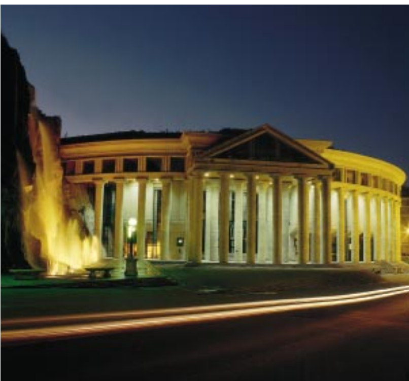
Palacio da Ópera (A Coruña)
