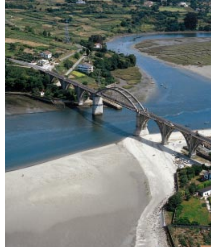
Ponte Pedrido, Paderne (A Coruña)
