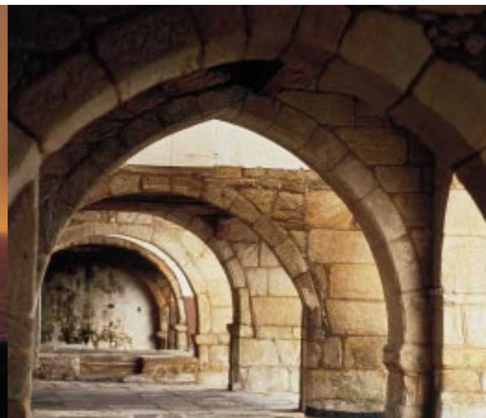
Muros (A Coruña)
