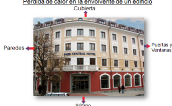
Pérdida de calor en la envolvente de un edificio
