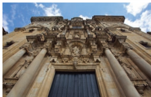
Fachada do mosteiro de San Salvador (Lorenzá)
