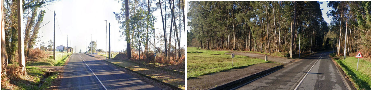
Fotografía 16 Imaxes do cruce e do treito afectado
