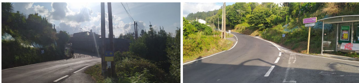
Fotografía 14 Imaxes do cruce e do treito afectado
