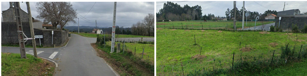
Fotografía 15 Imaxes do cruce e do treito afectado
