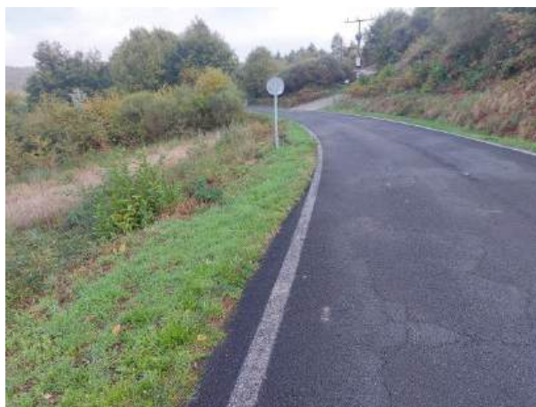
Fotografía 175: Estado actual - Treito 745
