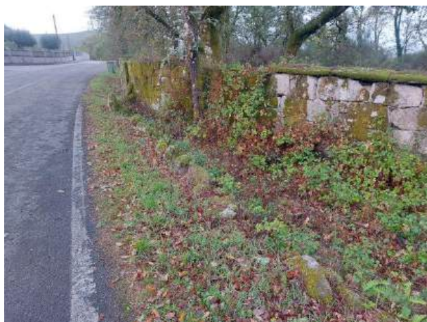
Fotografía 172: Estado actual - Treito 744
