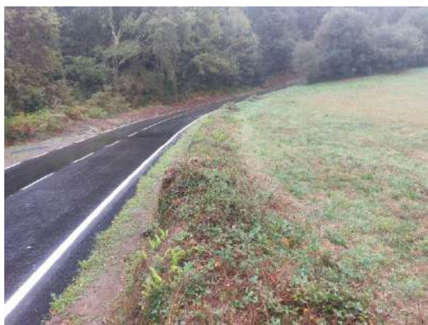
Fotografía 56: Estado actual - Treito 652
