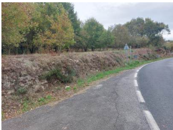
Fotografía 92: Estado actual - Treito 672
