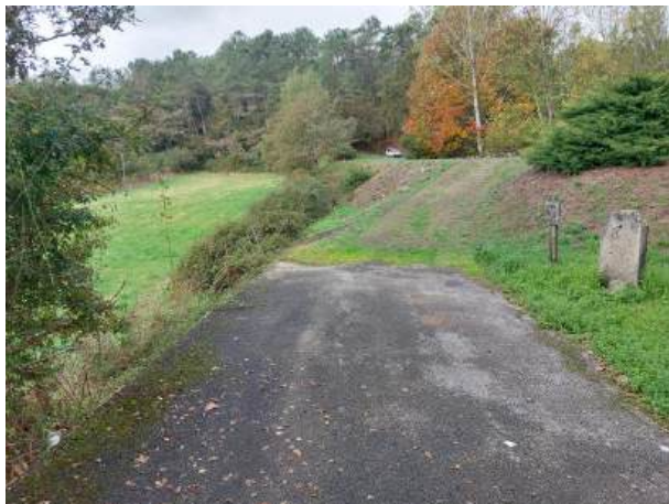
Fotografía 146: Estado actual - Treito 701
