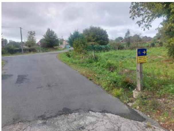
Fotografía 143: Estado actual - Treito 699
