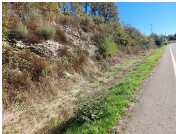
Fotografía 71: Estado actual - Treito 663
