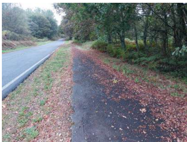
Fotografía 31: Estado actual - Treito 643
