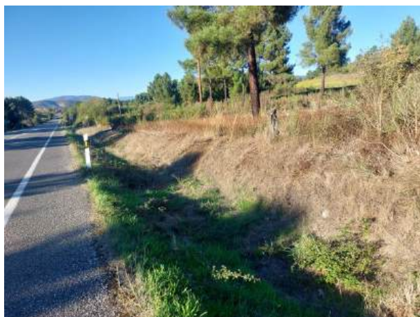
Fotografía 83: Estado actual - Treito 669
