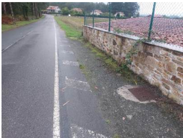
Fotografía 166: Estado actual - Treito 743
