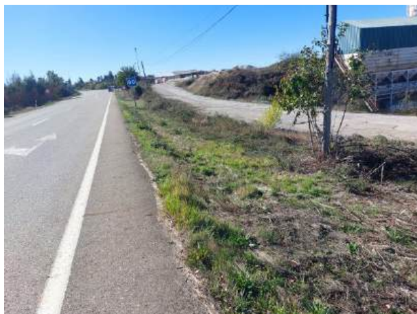
Fotografía 65: Estado actual - Treito 660_T1
