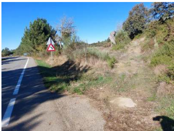
Fotografía 72: Estado actual - Treito 663
