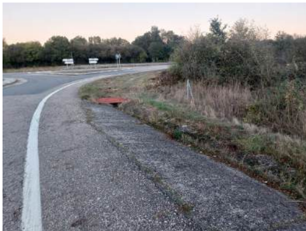
Fotografía 20: Estado actual - Treito 628
