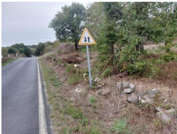
Fotografía 181: Estado actual - Treito 747
