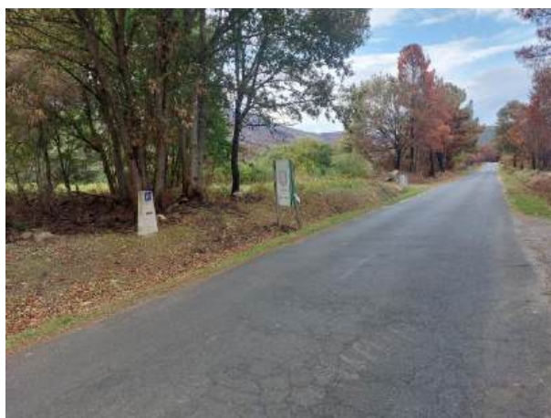
Fotografía 85: Estado actual - Treito 671
