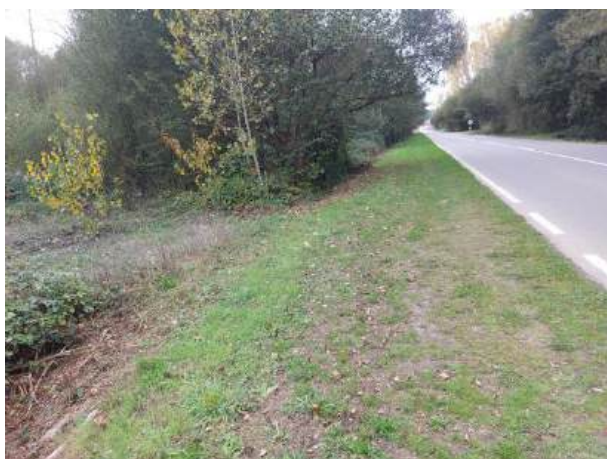
Fotografía 14: Estado actual - Treito 624
