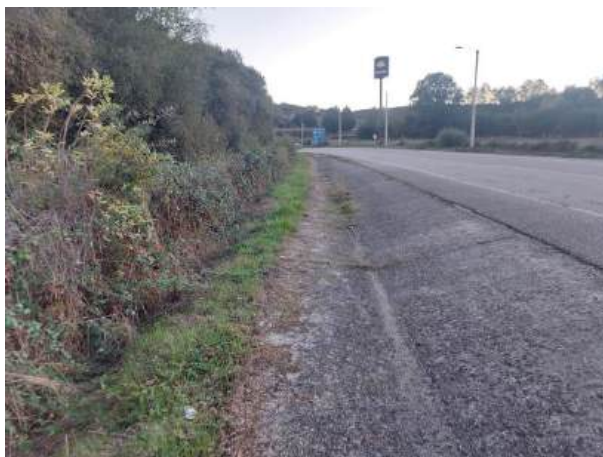
Fotografía 21: Estado actual - Treito 628
