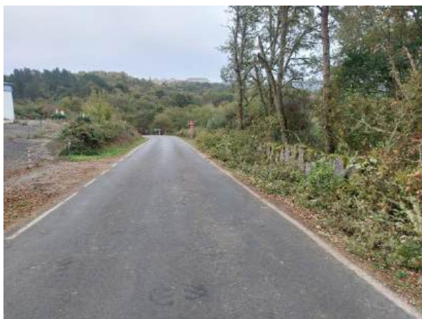
Fotografía 95: Estado actual - Treito 676
