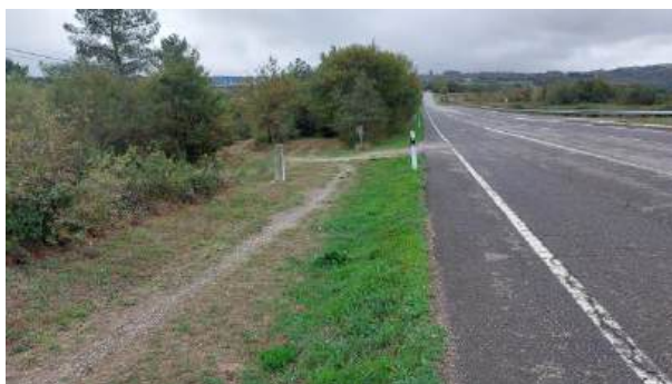
Fotografía 150: Estado actual - Treito 702
