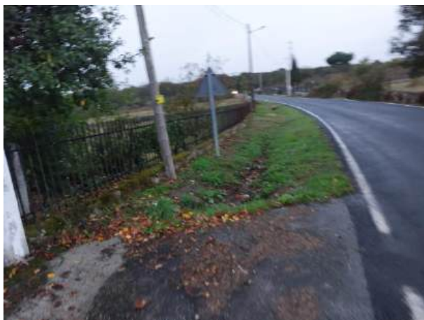
Fotografía 106: Estado actual - Treito 677_T4
