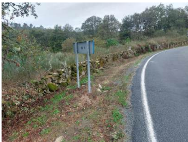
Fotografía 94: Estado actual - Treito 676
