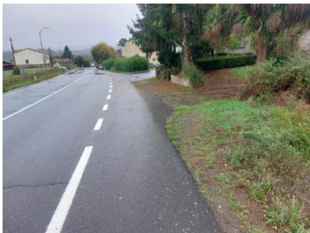
Fotografía 52: Estado actual - Treito 651
