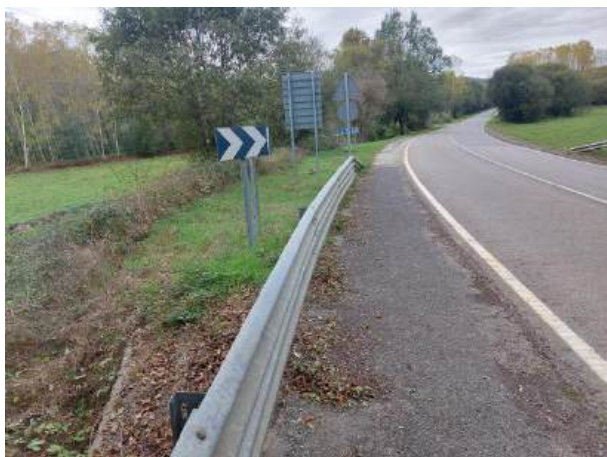
Fotografía 12: Estado actual - Treito 624
