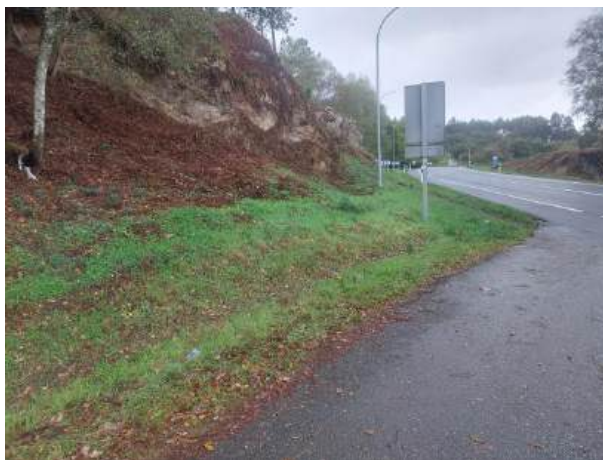
Fotografía 49: Estado actual - Treito 650
