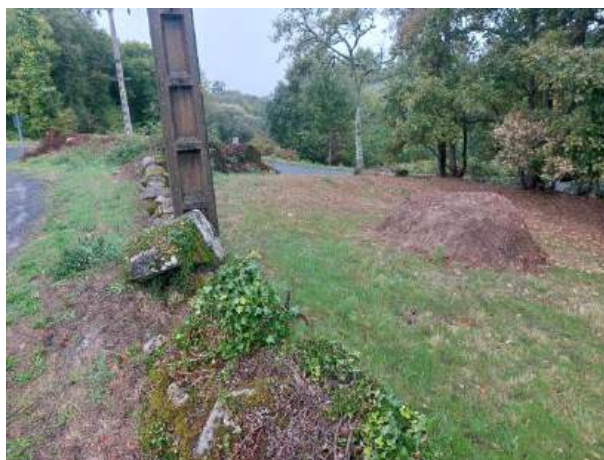
Fotografía 23: Estado actual - Treito 631
