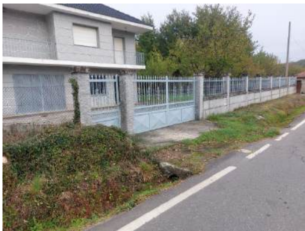
Fotografía 115: Estado actual – Treito 678_T2
