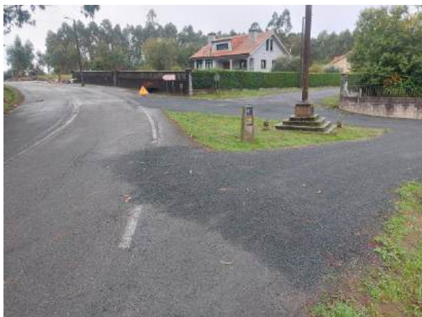
Fotografía 169: Estado actual - Treito 743
