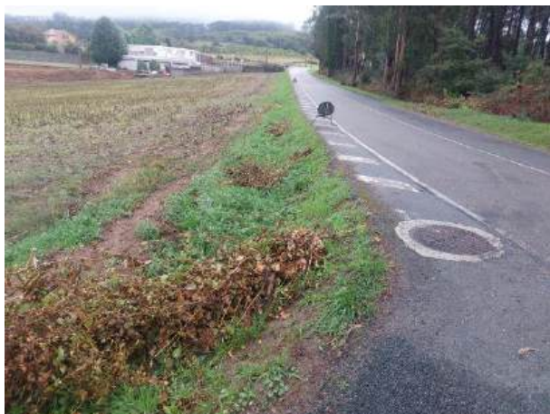
Fotografía 168: Estado actual - Treito 743
