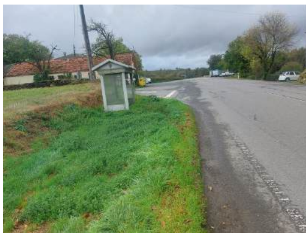
Fotografía 45: Estado actual - Treito 646
