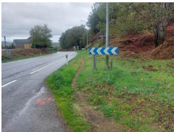
Fotografía 48: Estado actual - Treito 650
