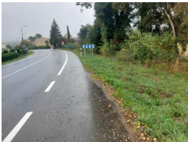
Fotografía 53: Estado actual – Treito 651
