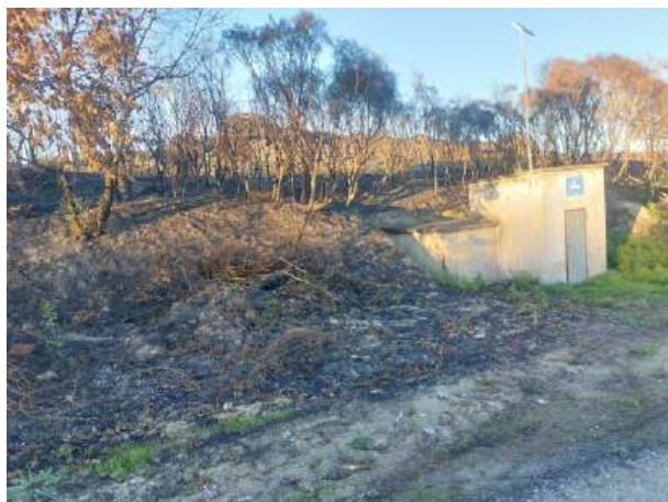
Fotografía 17: Estado actual - Treito 626
