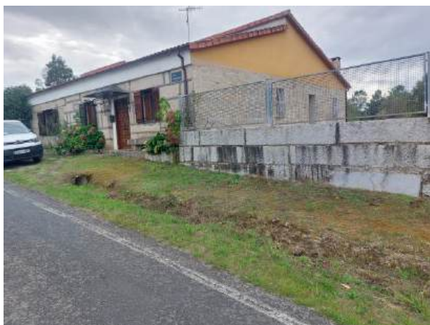
Fotografía 179: Estado actual - Treito 746
