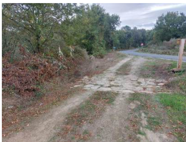
Fotografía 184: Estado actual - Treito 747
