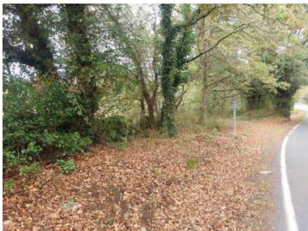
Fotografía 114: Estado actual - Treito 678_T2
