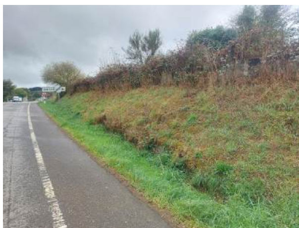
Fotografía 46: Estado actual - Treito 646
