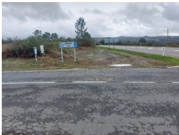
Fotografía 157: Estado actual - Treito 703
