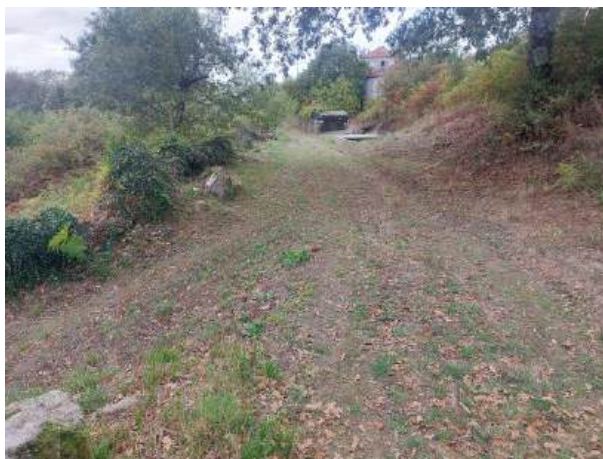
Fotografía 99: Estado actual - Treito 677_T1
