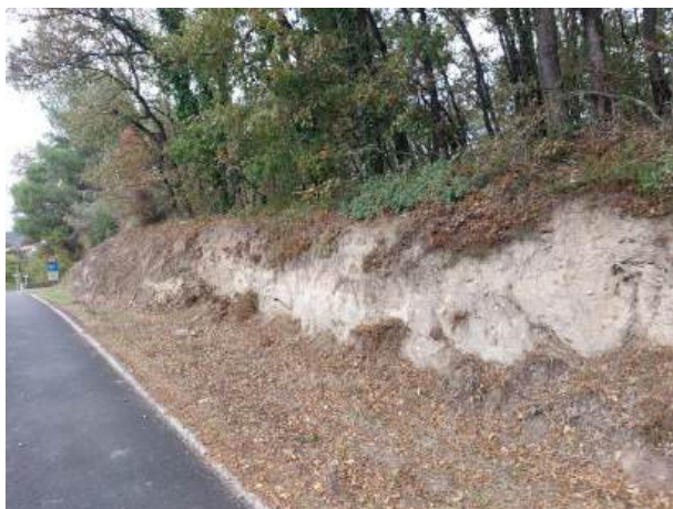
Fotografía 91: Estado actual - Treito 672
