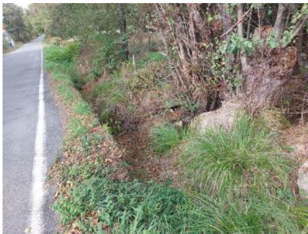
Fotografía 90: Estado actual - Treito 672
