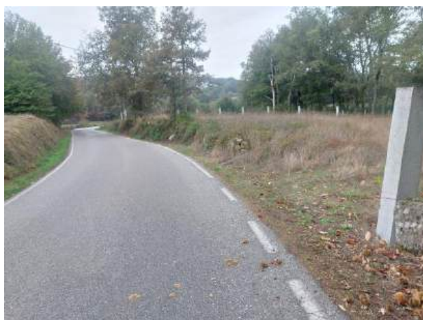
Fotografía 111: Estado actual – Treito 678_T1
