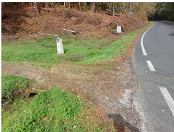
Fotografía 149: Estado actual - Treito 701
