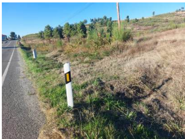
Fotografía 82: Estado actual - Treito 669
