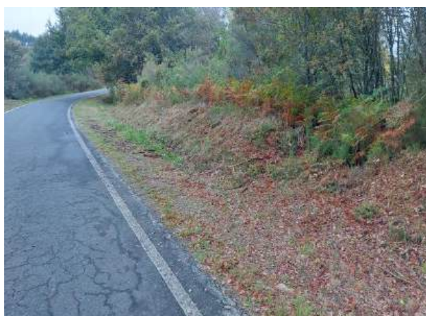
Fotografía 32: Estado actual - Treito 643
