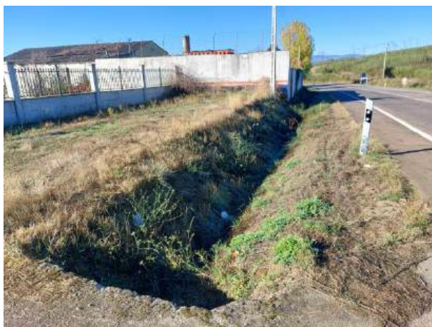
Fotografía 78: Estado actual - Treito 666
