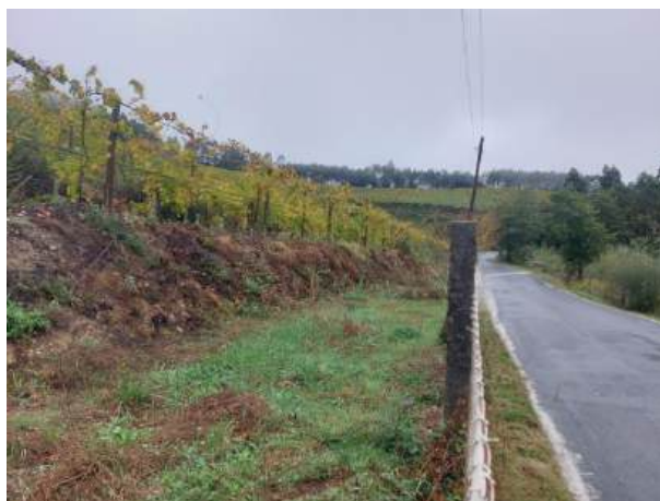
Fotografía 163: Estado actual - Treito 741
