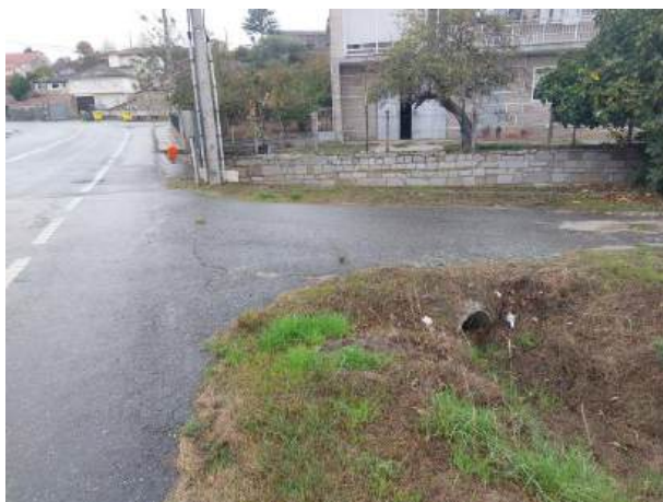
Fotografía 120: Estado actual - Treito 681
