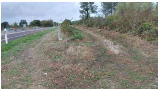
Fotografía 151: Estado actual - Treito 702
