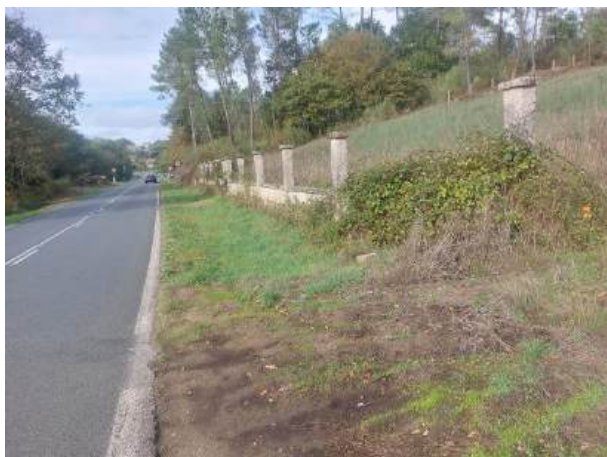
Fotografía 141: Estado actual - Treito 698_T2
