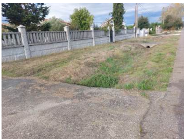
Fotografía 61: Estado actual - Treito 653
