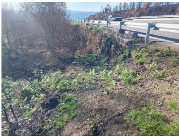
Fotografía 75: Estado actual - Treito 664
