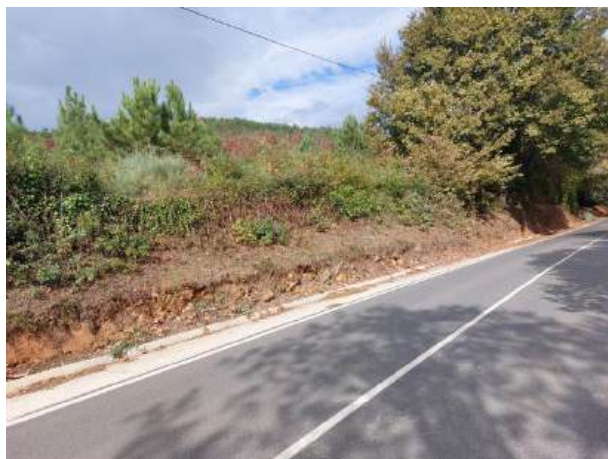
Fotografía 8: Estado actual - Treito 623
