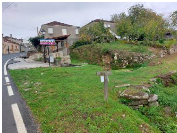
Fotografía 40: Estado actual - Treito 645_T1
