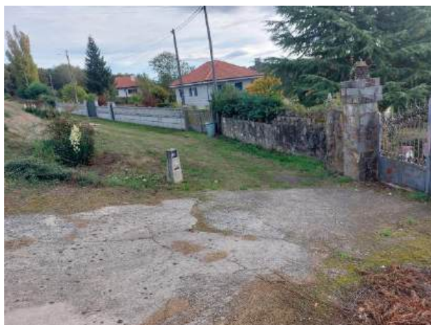
Fotografía 123: Estado actual - Treito 682
