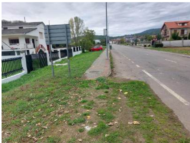
Fotografía 15: Estado actual - Treito 624
