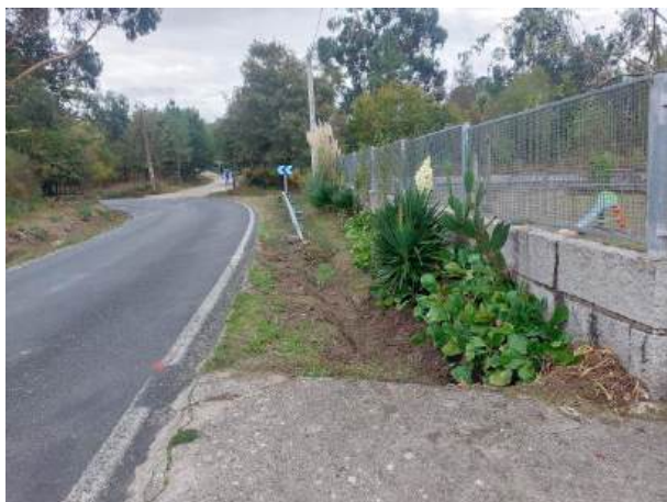
Fotografía 178: Estado actual - Treito 746
