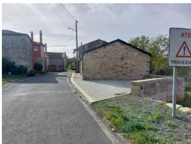
Fotografía 41: Estado actual - Treito 645_T2
