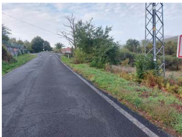
Fotografía 176: Estado actual - Treito 745
