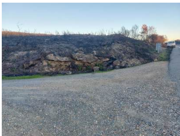
Fotografía 19: Estado actual - Treito 626
