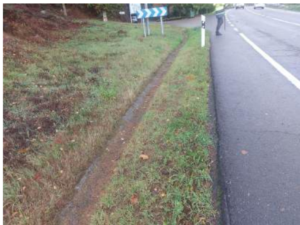
Fotografía 50: Estado actual - Treito 650
