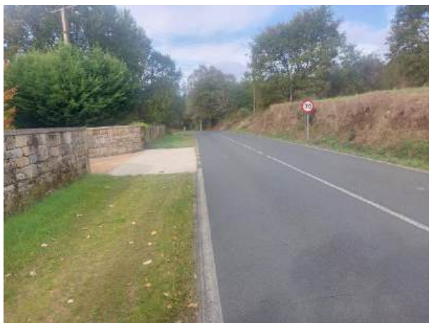
Fotografía 133: Estado actual - Treito 697
