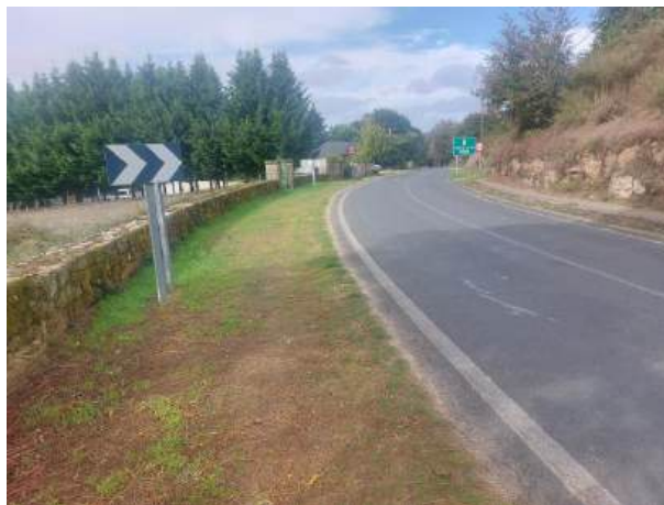
Fotografía 132: Estado actual - Treito 697
