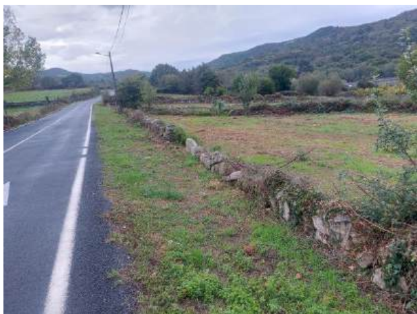
Fotografía 105: Estado actual - Treito 677_T3
