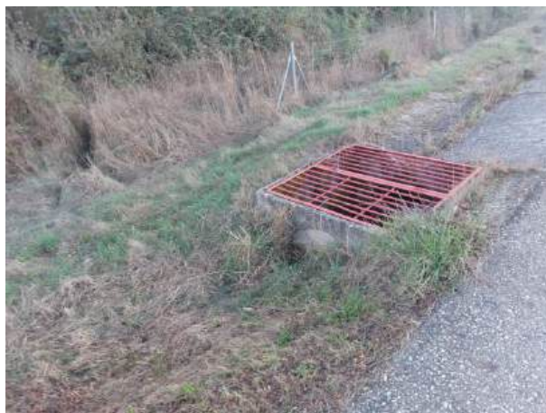
Fotografía 22: Estado actual - Treito 628
