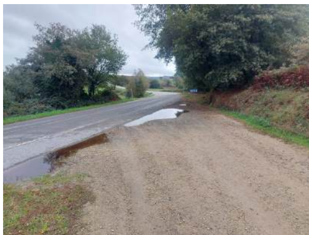
Fotografía 47: Estado actual - Treito 646
