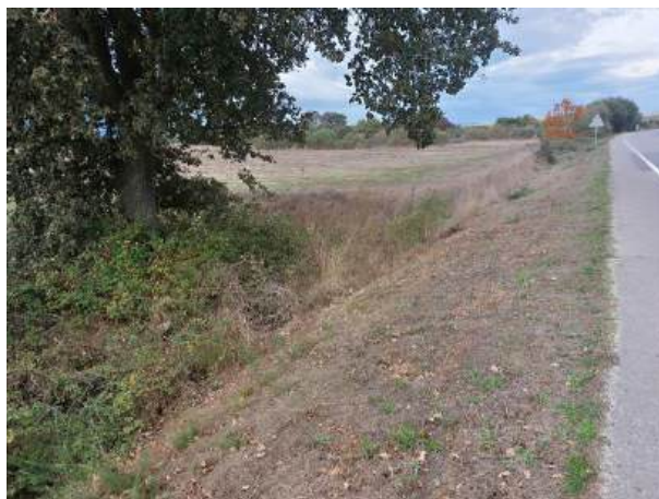
Fotografía 62: Estado actual - Treito 653
