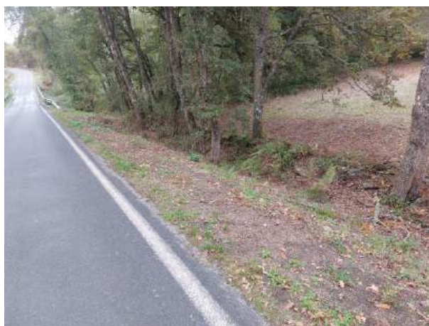
Fotografía 183: Estado actual - Treito 747
