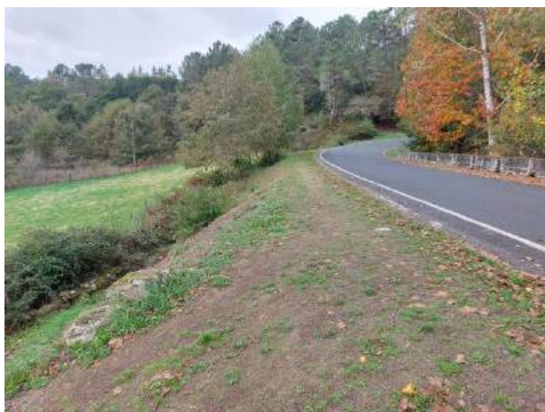
Fotografía 147: Estado actual - Treito 701
