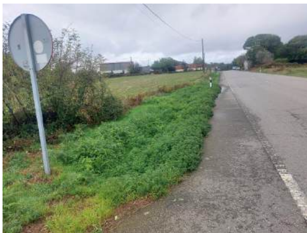
Fotografía 44: Estado actual - Treito 646
