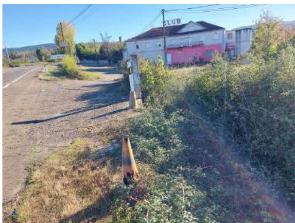
Fotografía 80: Estado actual - Treito 666
