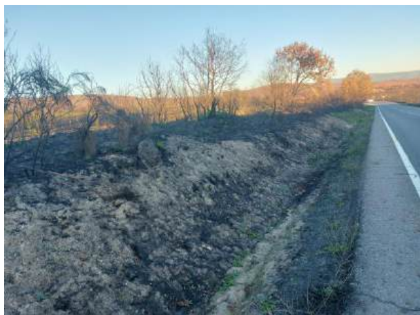
Fotografía 18: Estado actual - Treito 626
