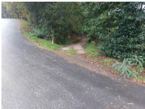
Fotografía 162: Estado actual - Treito 741
