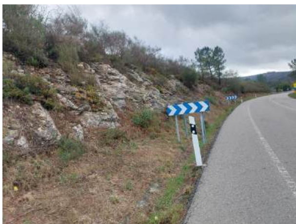
Fotografía 155: Estado actual - Treito 703
