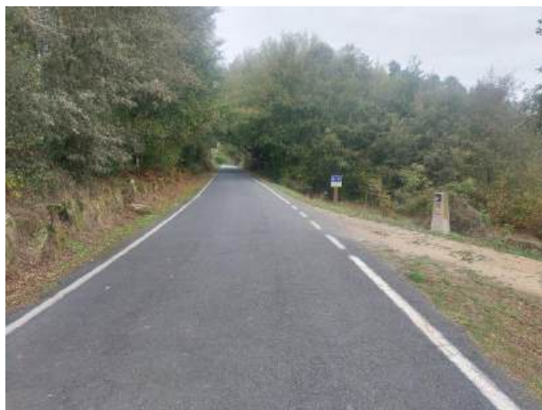
Fotografía 109: Estado actual - Treito 678_T1
