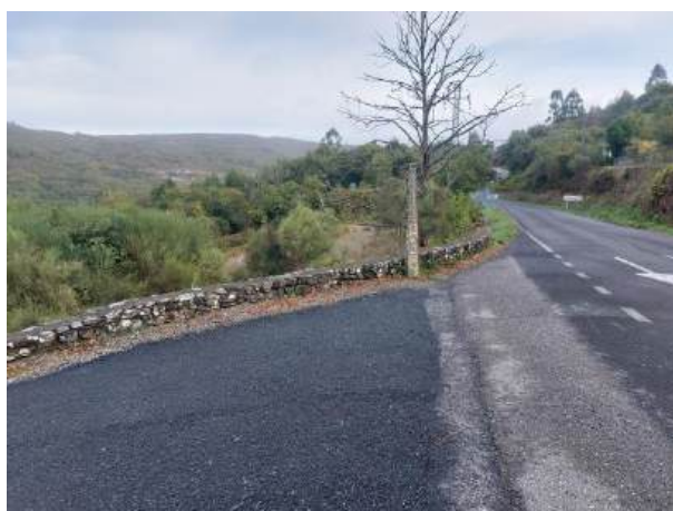
Fotografía 174: Estado actual - Treito 745
