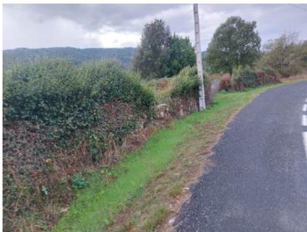
Fotografía 104: Estado actual - Treito 677_T3
