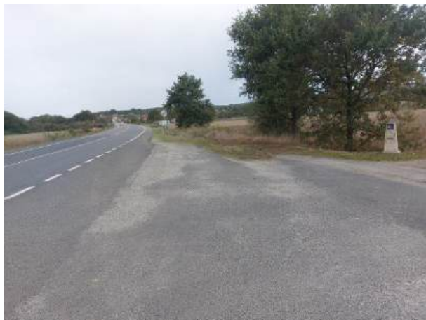
Fotografía 117: Estado actual - Treito 681
