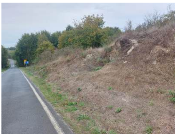
Fotografía 182: Estado actual - Treito 747
