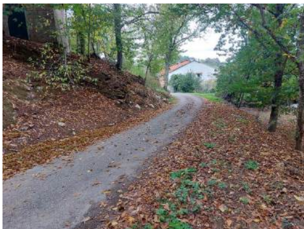
Fotografía 6: Estado actual - Treito 618
