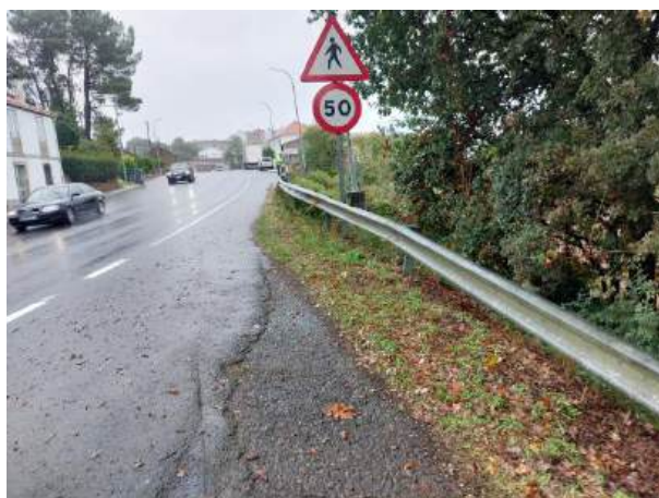
Fotografía 159: Estado actual - Treito 706
