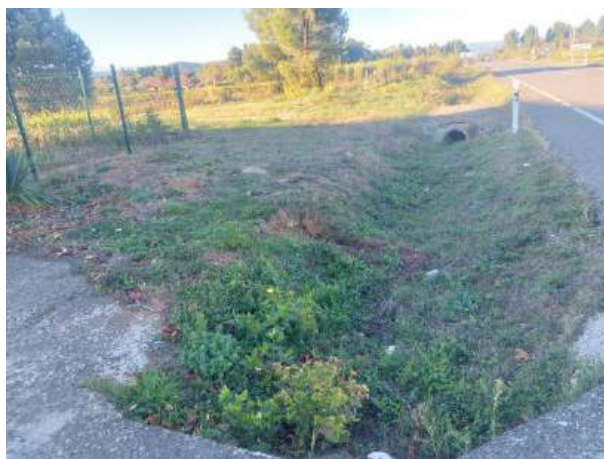
Fotografía 1: Estado actual - Treito 617
