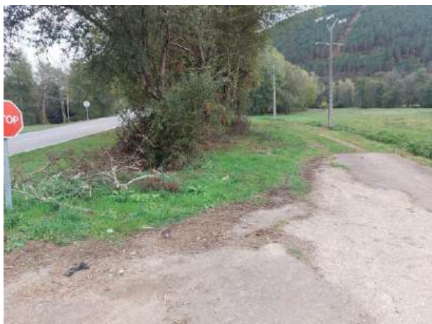
Fotografía 13: Estado actual - Treito 624
