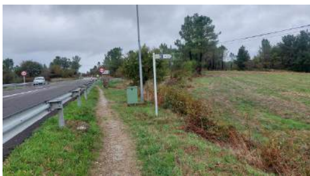
Fotografía 153: Estado actual - Treito 702
