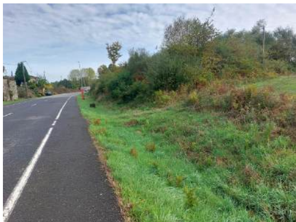
Fotografía 35: Estado actual - Treito 644
