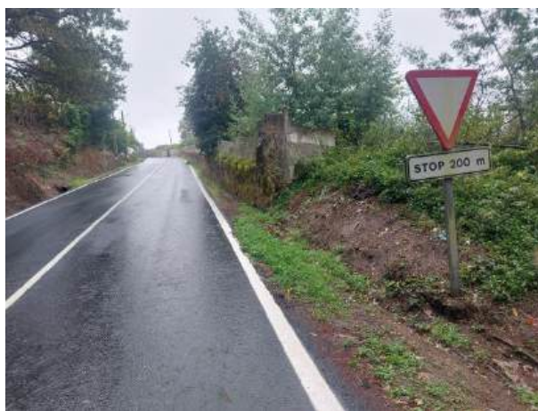
Fotografía 55: Estado actual - Treito 652
