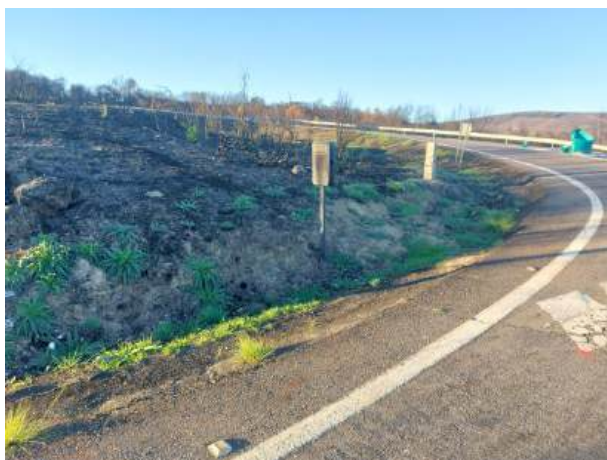
Fotografía 16: Estado actual - Treito 626
