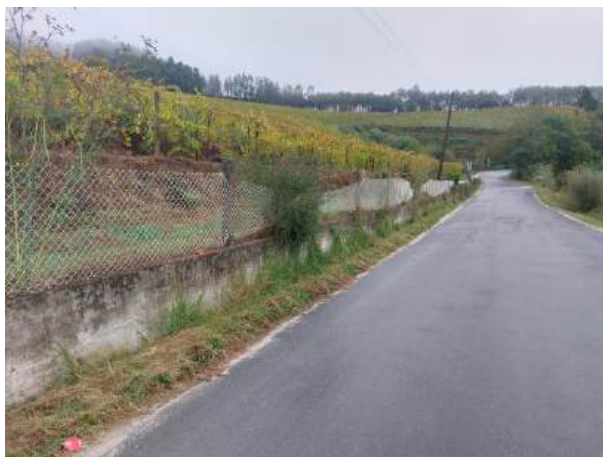
Fotografía 164: Estado actual - Treito 741
