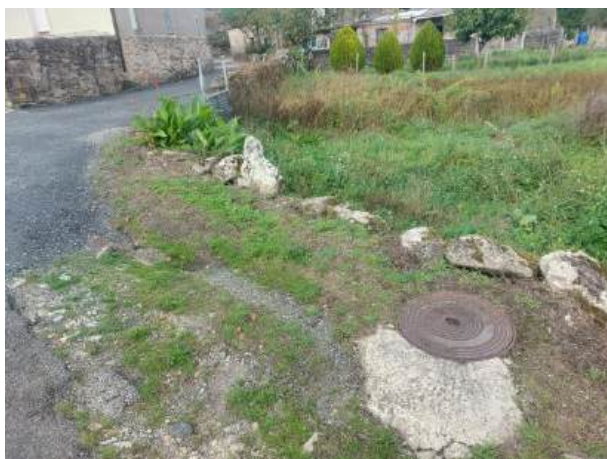
Fotografía 145: Estado actual - Treito 699
