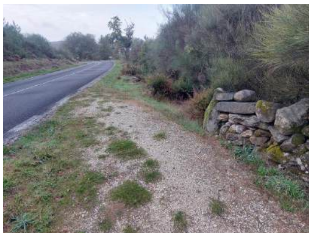
Fotografía 173: Estado actual - Treito 744
