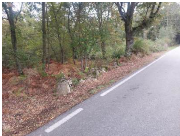
Fotografía 110: Estado actual - Treito 678_T1
