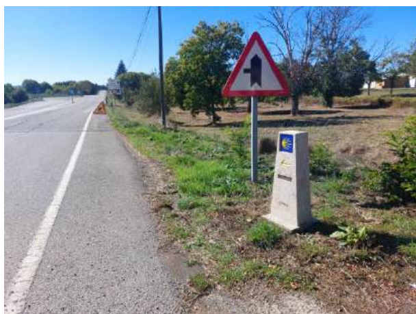
Fotografía 66: Estado actual - Treito 660_T2
