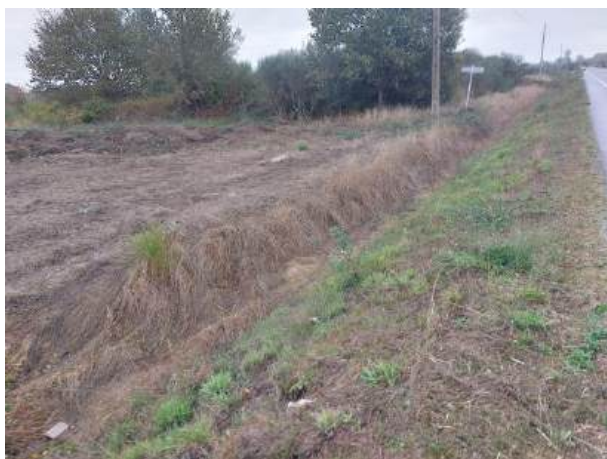
Fotografía 118: Estado actual - Treito 681
