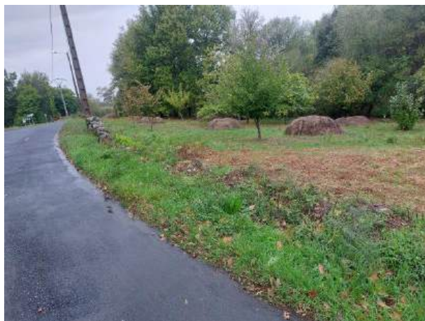
Fotografía 24: Estado actual - Treito 631
