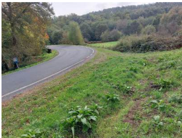
Fotografía 148: Estado actual - Treito 701
