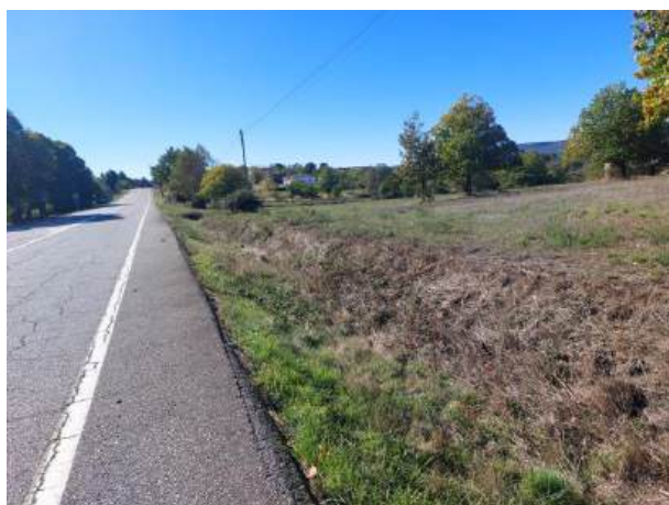
Fotografía 67: Estado actual - Treito 660_T2
