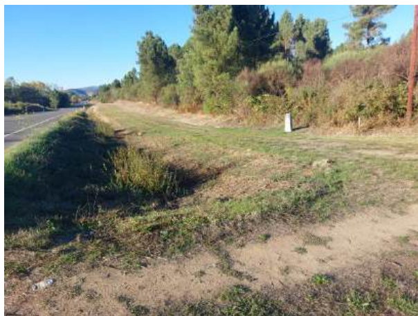
Fotografía 84: Estado actual - Treito 66
