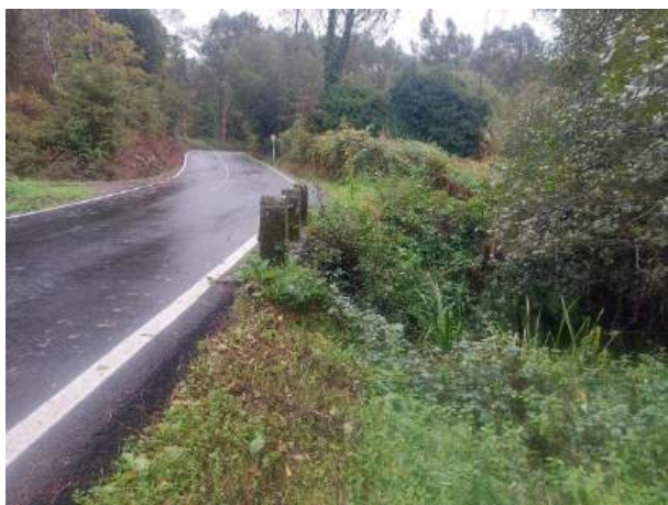
Fotografía 58: Estado actual - Treito 652
