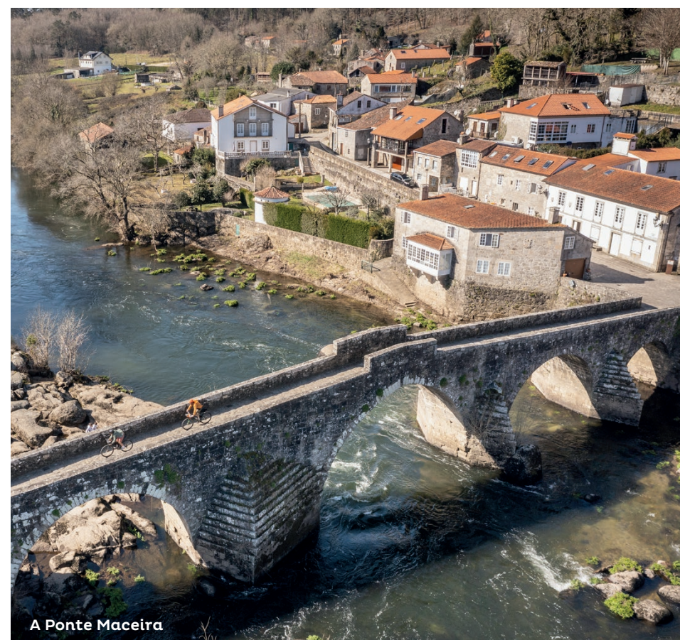
A Ponte Maceira
