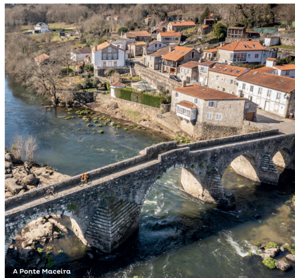
A Ponte Maceira
